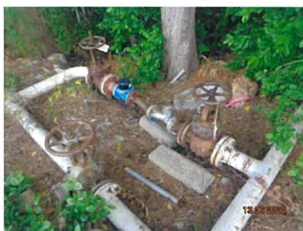
ภาพที่ 2-4 ท่อน้ำเสียที่ส่งไปบำบัดยัง บริษัท พีทีที โกลบอล เคมิคอล จำกัด (มหาชน)
