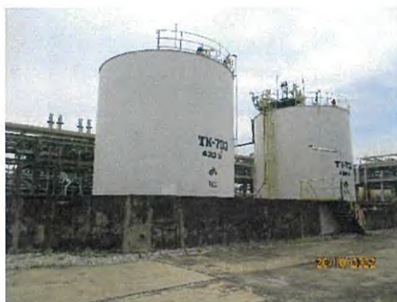
ภาพที่ 2-30 Bund Wall บริเวณถังเก็บสารเคมี
