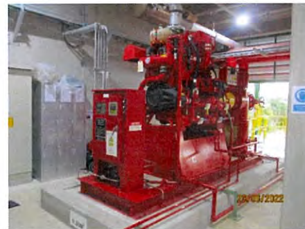
ภาพที่ 2-36 ปั๊มดับเพลิง (Fire Pump)
