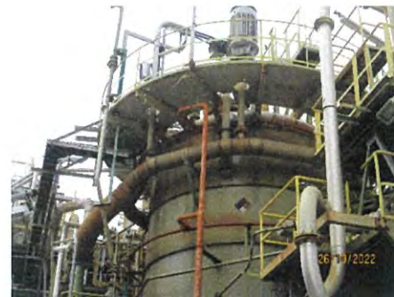
ภาพที่ 2-18 ระบบดัดน้ำภายนอกถังปฏิกรณ์
