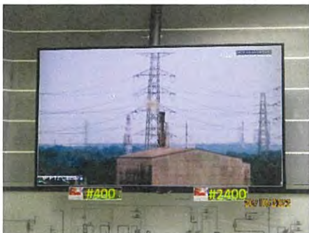
ภาพที่ 2-1 CCTV สำหรับตรวจสอบเปลวไฟของ Flare
